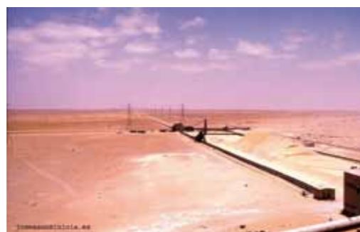
Technik in der Wüste: das Förderband der Krupp GmbH transportiert Phosphatgestein zur Verschiffung an die Küste der Westsahara
